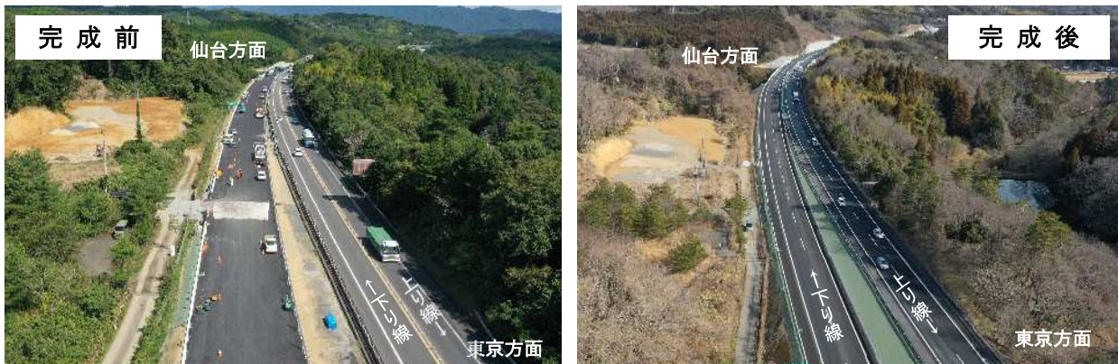
いわき中央IC～いわき四倉IC間(好間トンネル付近)の4車線化前後の状況
