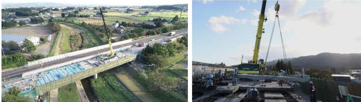
東北道 滝名川橋床版取替工事
